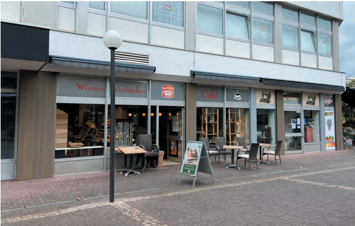
Abbildung 31: Leuchtyp am Houiller Platz. Pfasterung in Reihe und Ellenbogenmuster gelegt. (ProjektStadt 2020)
