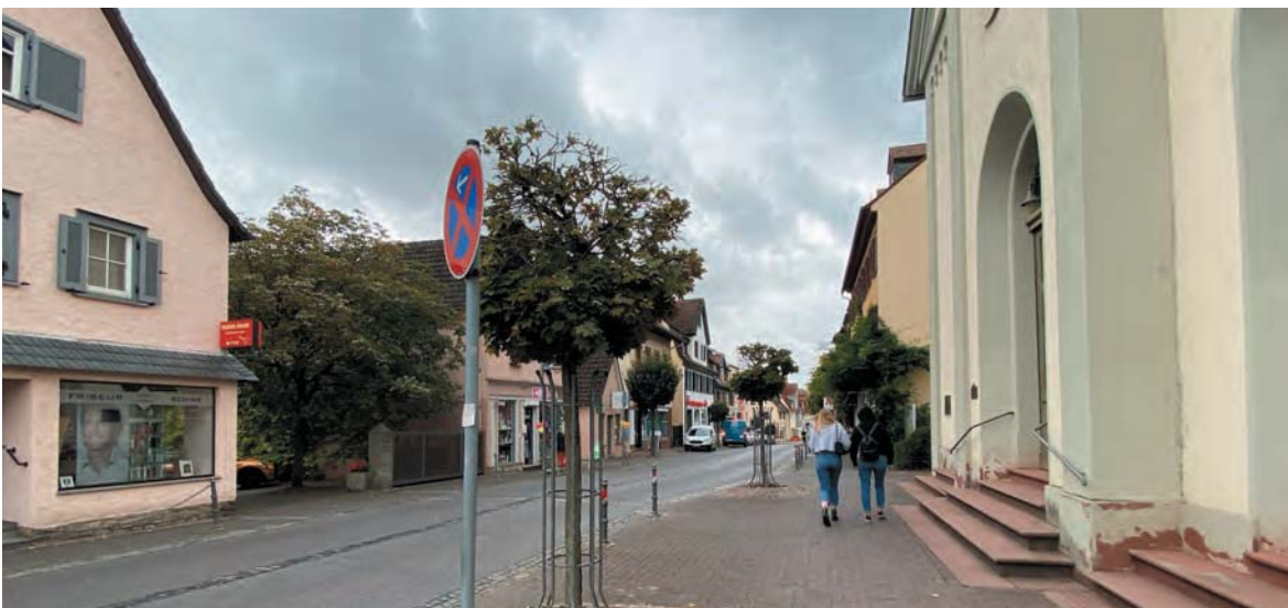
Abbildung 35: Erscheinungsbild Hugentottenstraße, Baumstandorte und sanierungsbedürftiger Pflasterbelag (ProjektStadt 2020)
